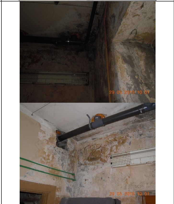
Fotofiksācija Nr.45 Telpa Nr.6, telpu grupa Nr.013 Mitruma radīti bojājumi
