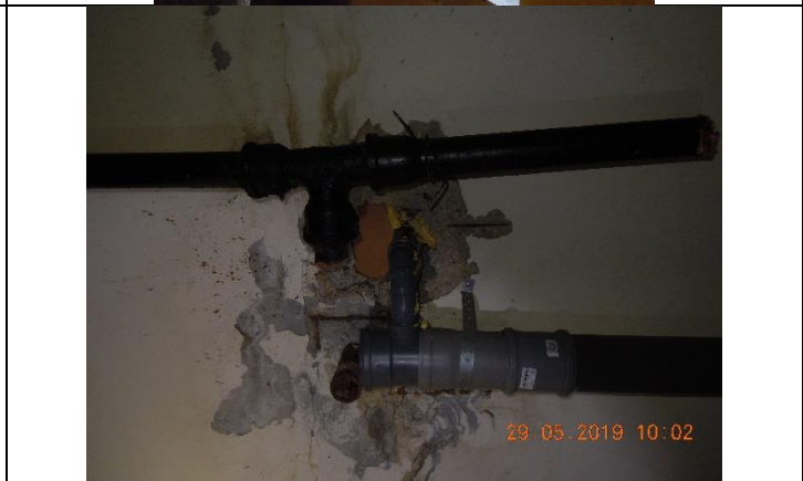
Fotofiksācija Nr.44 Telpa Nr.7, telpu grupa Nr.013 Daļējs iekšējās kanalizācijas tīklu remonts Atsegts pārseguma stiebrojums
