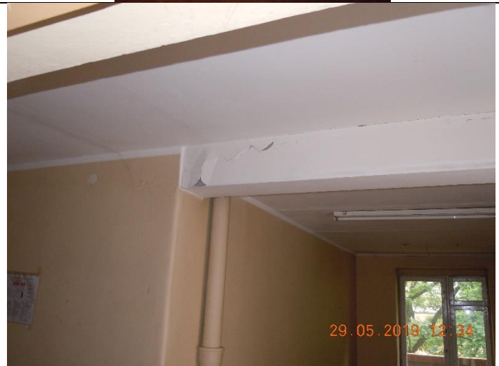
Fotofiksācija Nr.171 Telpa Nr.1, telpu grupa Nr.008 Konstatēta plaisa sijas balstījuma vietā
